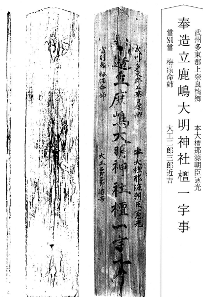
豊鹿島神社本殿修理工事報告 より引用
